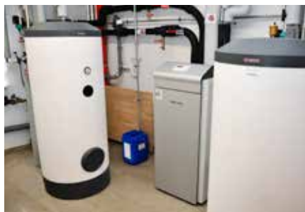
Abb. links: Diskussion unter Experten (v.l.): Bürgermeister Josef Schmid, Architekt Josef Weiniger sowie Helmut Paulus und Gerd Wolfrum von STIEBEL ELTRON. Abb. rechts: Sole | Wasser-Wärmepumpe WPF 13 mit Puffer- und Warmwasserspeicher.
